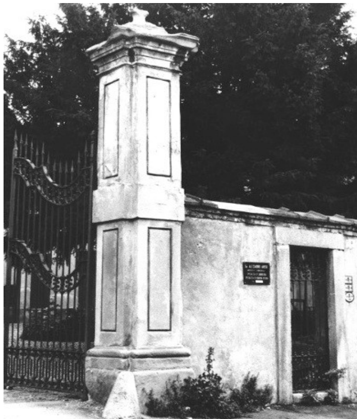
Villa Birago, particolare dell'ingresso [1991].
