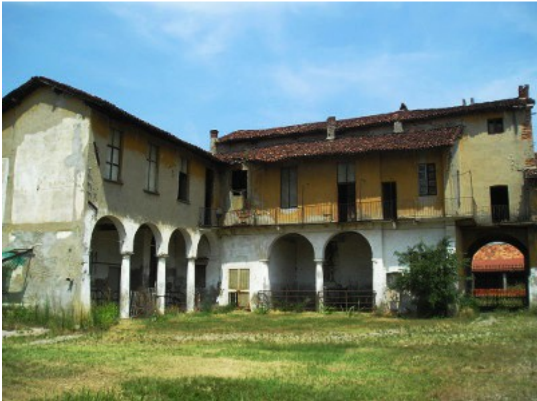
Cascina Cavarossa, portico della residenza nobile [2014].
