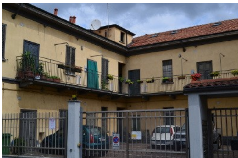
S. Maurizio al Lambro, corte Biffi, ballatoi meridionali [2014].
