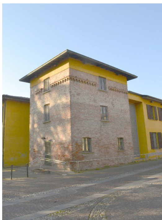
Villa Besozzi Casati, la torre settentrionale [2014].
