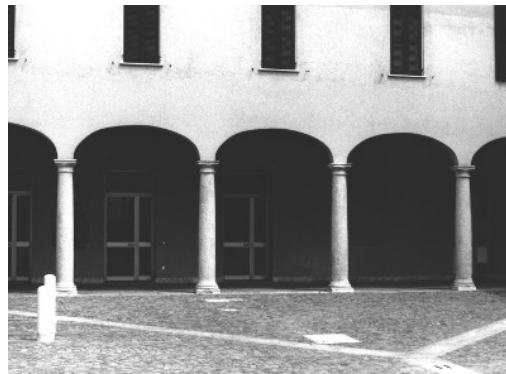
Villa De' Mester Citterio, portico del cortile [1991].
