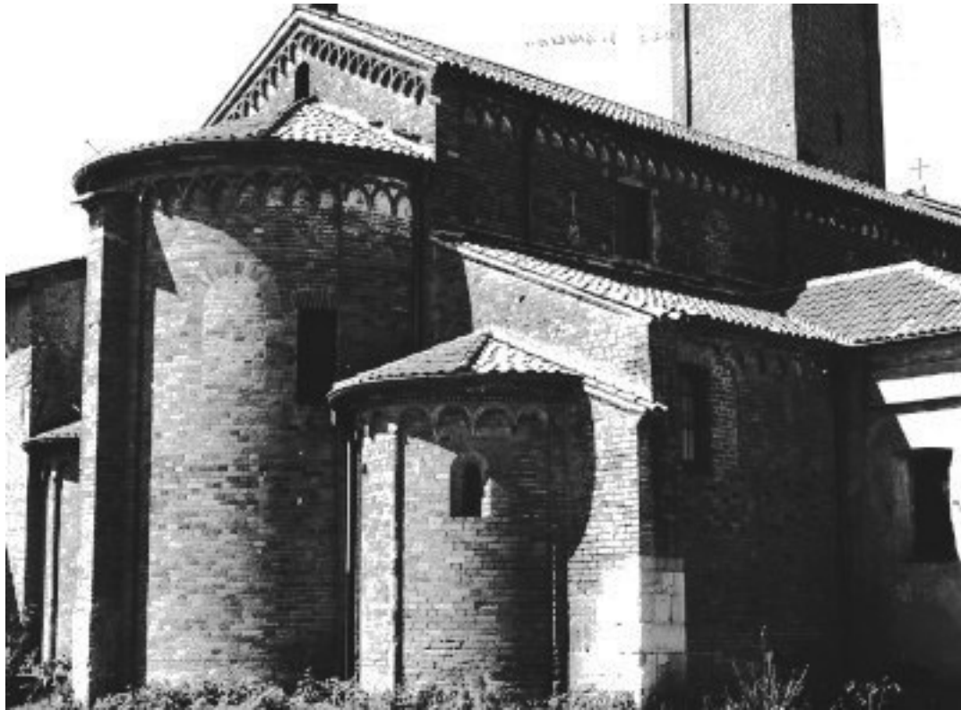
S. Giuliano, parte absidale della parrocchiale [1991].
