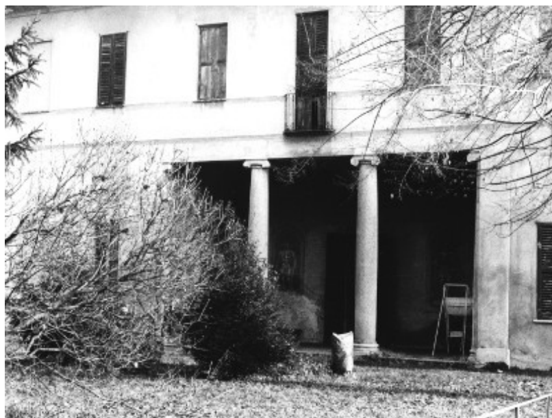
S. Giuliano, Villa Visconti Cacherano facciata occidentale [1991].
