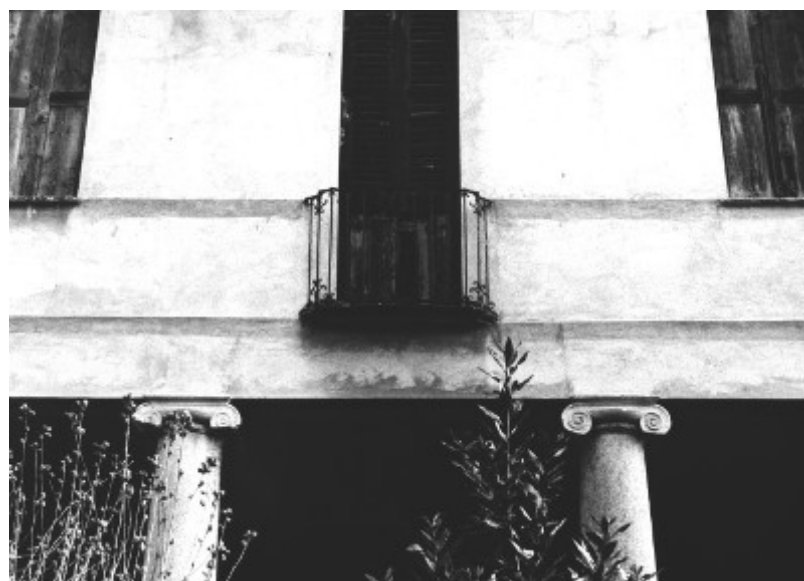
S. Giuliano, Villa Visconti Cacherano particolare del portico occidentale [1991].
